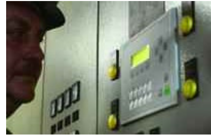
Bild 2: Kompakte Einheit aus SPS und Operator Panel: Simatic C7-613 macht den Besinterungsprozess transparent
